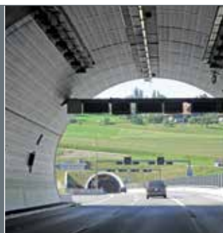
Traseu de cabluri
